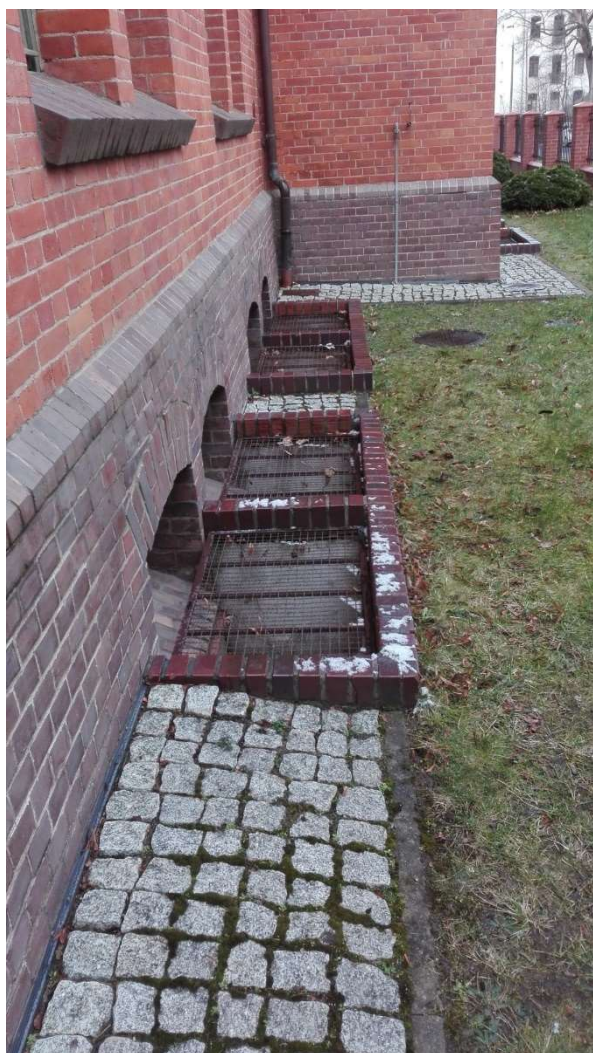
Zdjęcie nr 2. Widok 2 podwójnych studzienek przyokiennych podlegających remontowi
